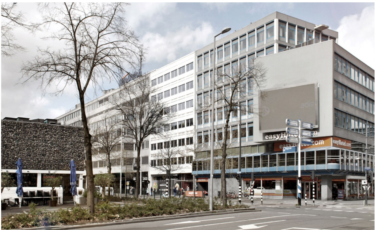
Voormalige gevel Westblaak
