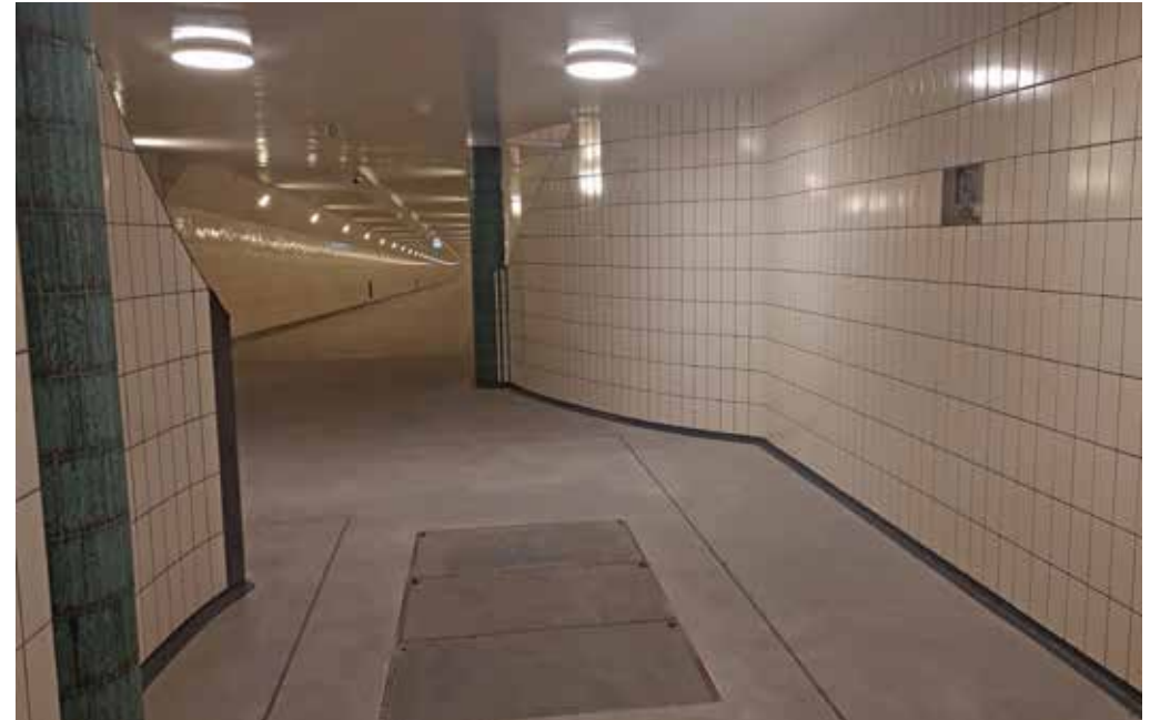
Voorhal van de gerestaureerde voetgangerstunnel
