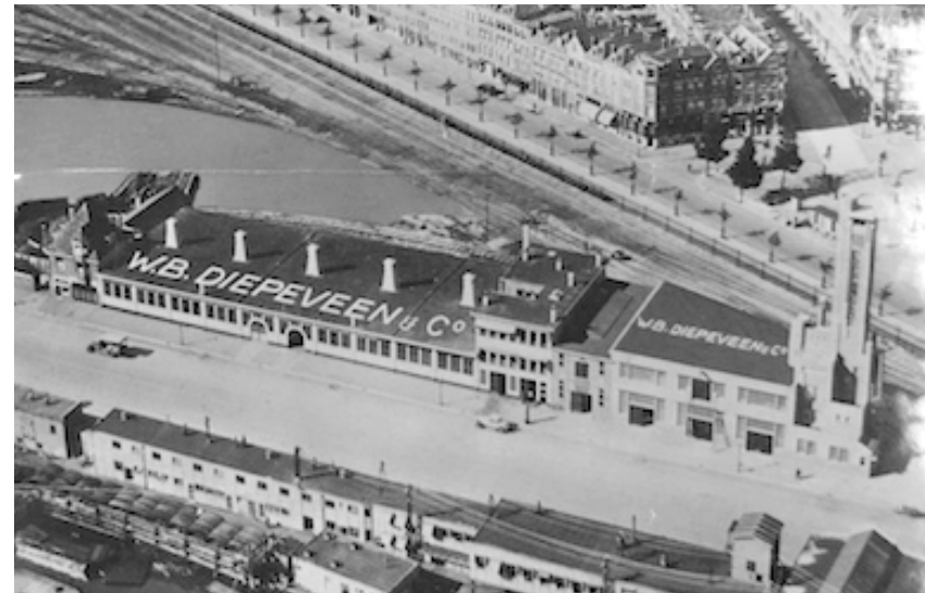
historische foto Diepeveen complex
