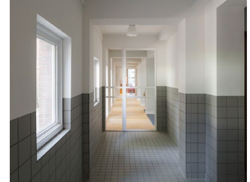
Leistenen vloertegels van de kerkzaal hergebruikt.
