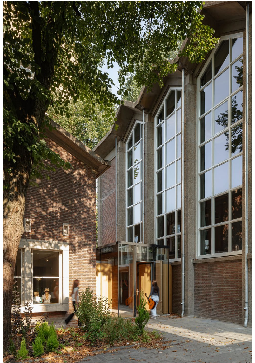
De tweezijdige ingang sluit naadloos aan op de bestaande gebouwen.
