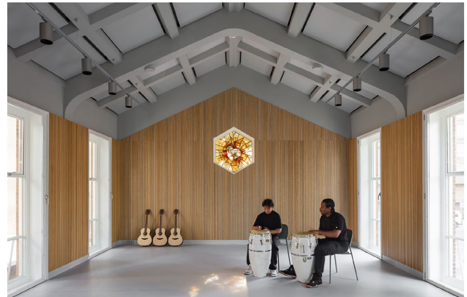
Dankzij stralingspanelen in het plafond blijven de betonnen spanten zichtbaar.
