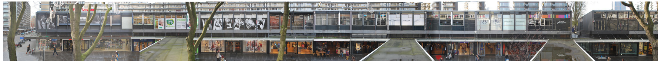
blok B Westgevel
