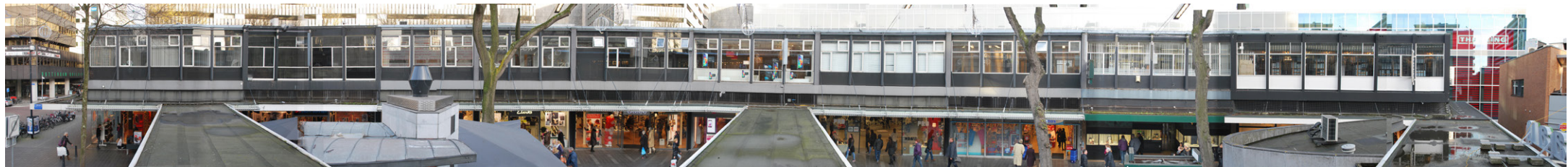
blok A Oostgevel
