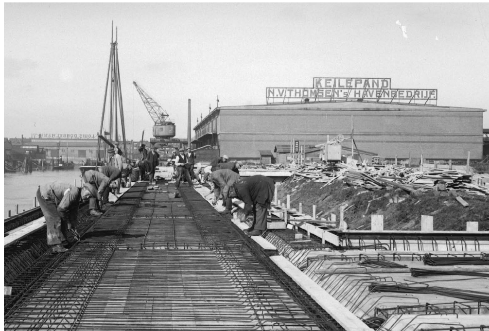
Keilepand, met kade en aanlegsteiger in aanbouw aan de Keilehaven
