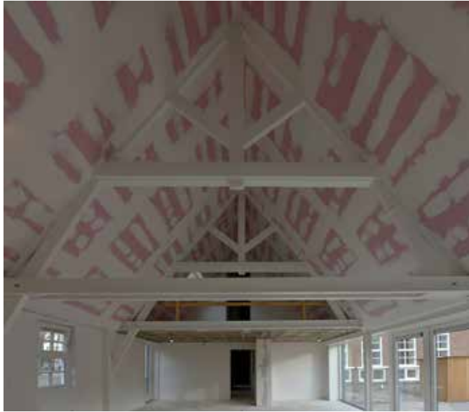
Foto's interieur tijdens verbouwing.
