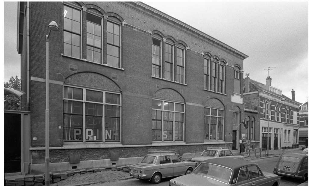
Voormalig Prinsesseschool in de 2e Pijnackerstraat - 1972
