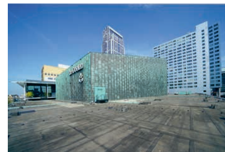
Het vernieuwde dak rond de grote zaal wordt binnenkort afgebouwd met vlonders, retentiekragen en groen. (Foto: Tjerk van Duinen)
