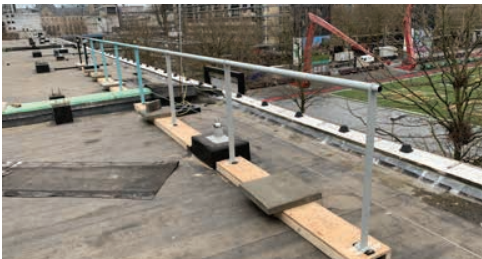
De proefopstelling van het hekwerk maakte duidelijk dat zwart het minst zichtbaar zal zijn gezien vanaf de straat en plein. (Foto: Kraaijvanger Architecten)
