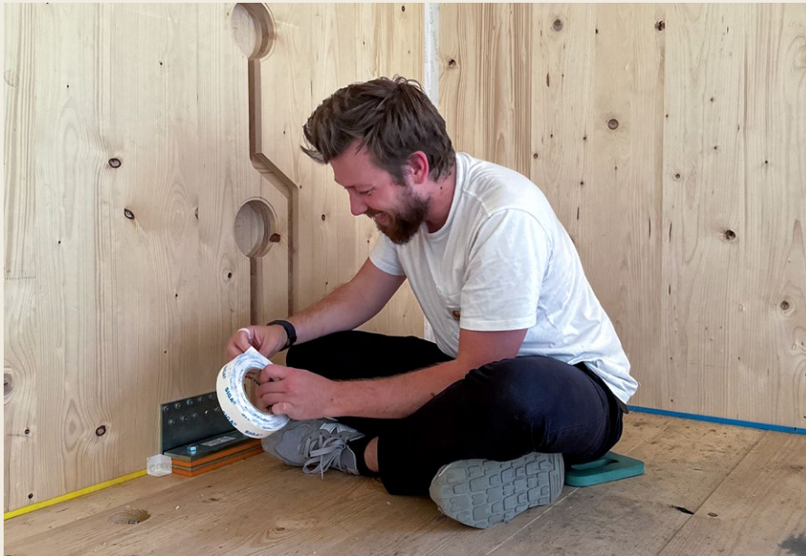
Luchtdicht taping. Foto: JADE architecten
