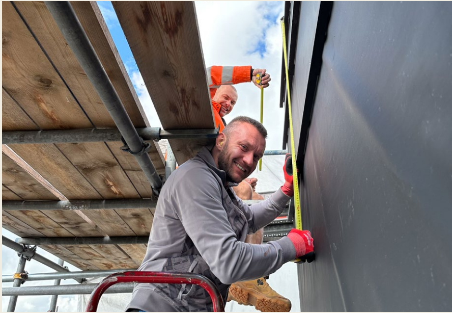
Plaatsing van de gevel. Foto: JADE architecten
