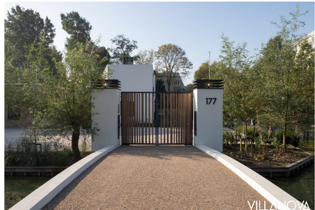
Details van de poort reflecteren de nieuwe architectuur
