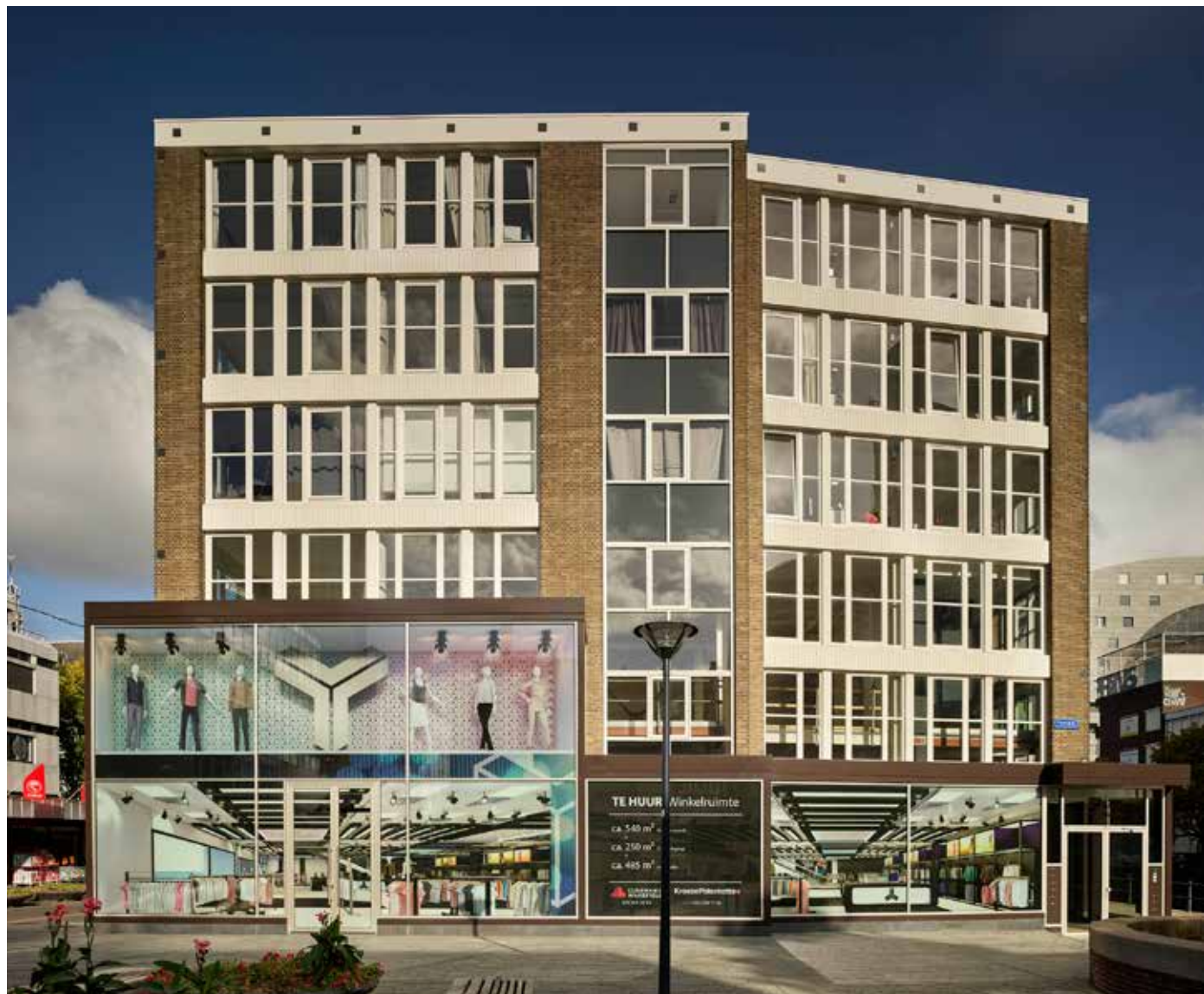
gevel Vlasmarkt _ ramen erker en plint aan binnenzijde tijdelijk beplakt
