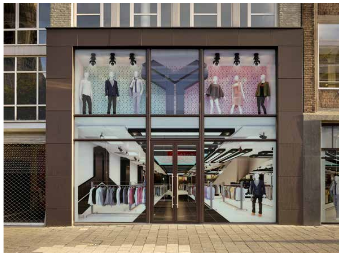
gevel Hoogstraat _ ramen erker en plint aan binnenzijde tijdelijk beplakt
