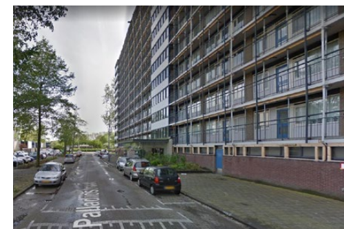
Oorspronkelijke situatie galerijgevel
