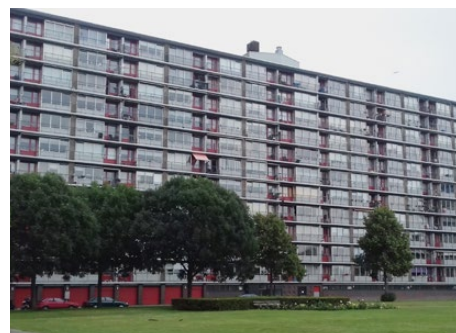
Oorspronkelijke situatie balkongevel
